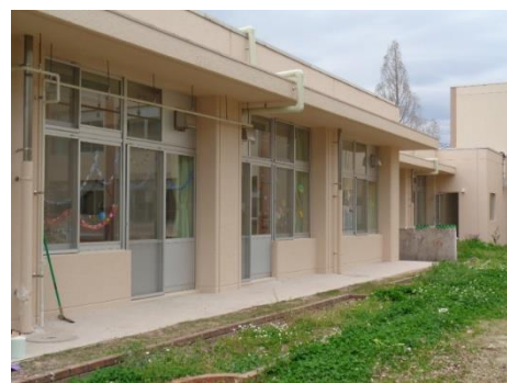
▲附属小学校外壁北面
