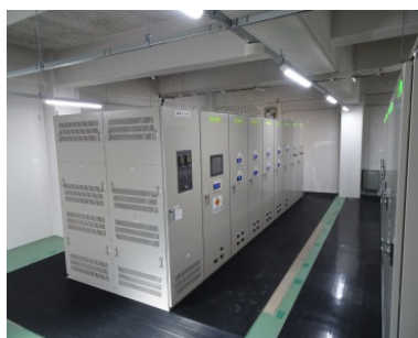
▲ 受変電設備整備
