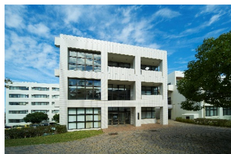
▲ 情報処理センター 空調設備・屋上防水改修
