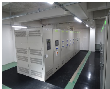
▲ 受変電設備整備
