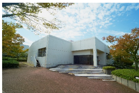
▲ 共通講義棟実習室3 空調設備改修
