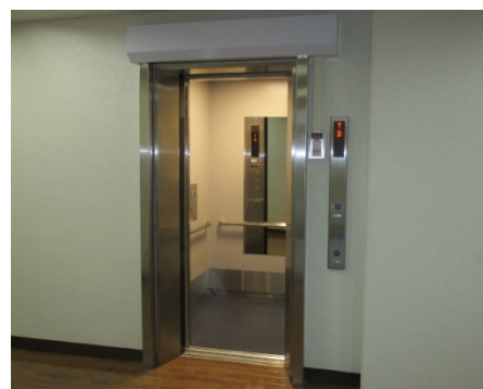
▲平成30年度に改修した図書館エレベーター
