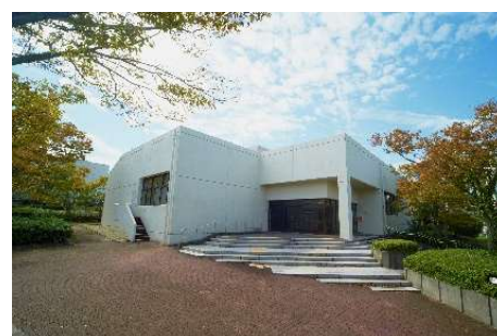
▲空調設備改修(共通講義棟205講義室)
