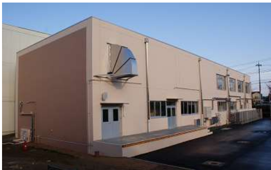
（旧校舎棟 外部改修）
