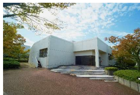
▲(嬉野台)空調機取換工事 (共通講義棟1階院生研究室112号室)
